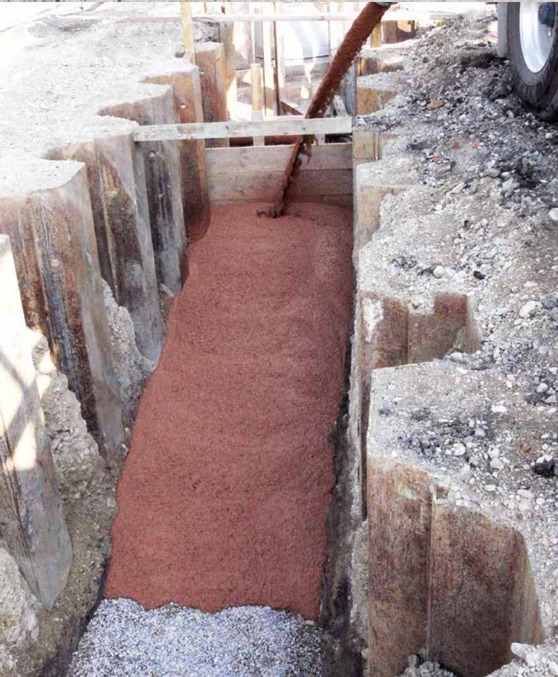
WOPFINGER VERFÜLLMATERIAL (WVM®) WIRD AUS AUFBEREITETEN, REZYKLIERTEN, MINERALISCHEN HOCHBAURESTMASSEN (RMH) HERGESTELLT.
